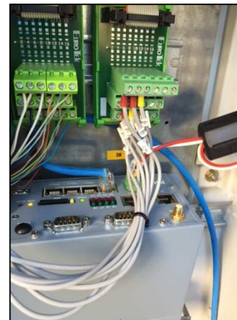
Cablaggio e sistema di comunicazione verso il centro controllo
