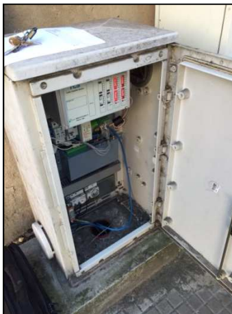
Armadio stradale di contenimento apparati
