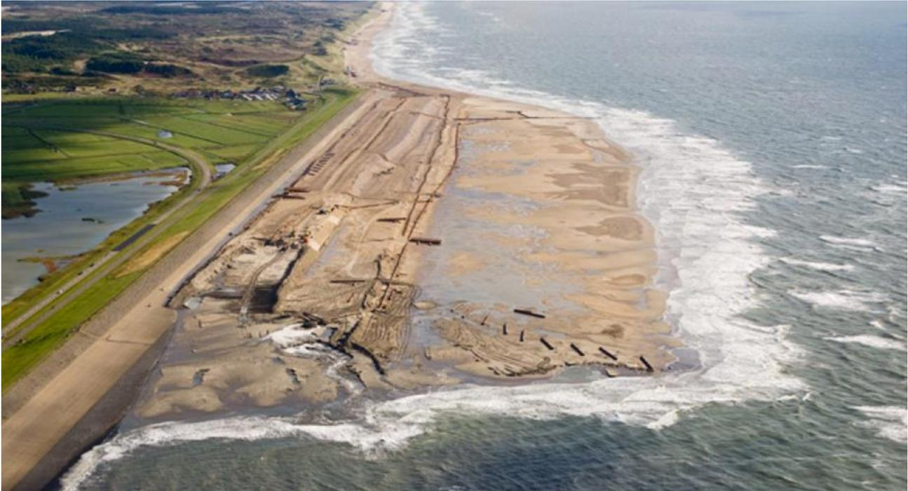
Ripascimento della spiaggia (immagine inizio 2015). La distribuzione a terra avviene tramite bulldozer e ruspe.
